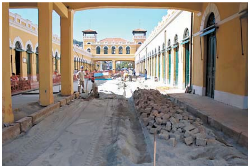
Obras da Ala Sul levaram um ano para ser finalizadas. Desde 1931 o Mercado não ganhava uma reforma completa
