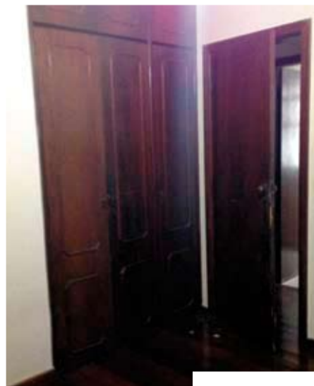
As antigas portas do armário foram substituídas por portas deslizantes de espelho. A estrutura interna do móvel, que estava em ótimo estado, foi mantida
