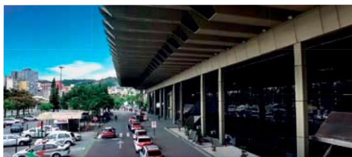
FLORIANÓPOLIS REFORMA DA RODOVIÁRIA
