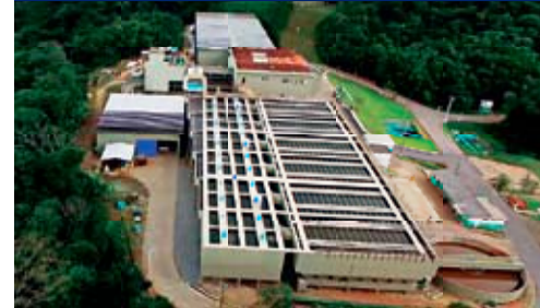
PALHOÇA ESTAÇÃO DE TRATAMENTO DE ÁGUA
