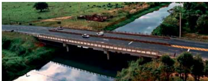
SÃO JOSÉ PONTE SOBRE O RIO FORQUILHAS
